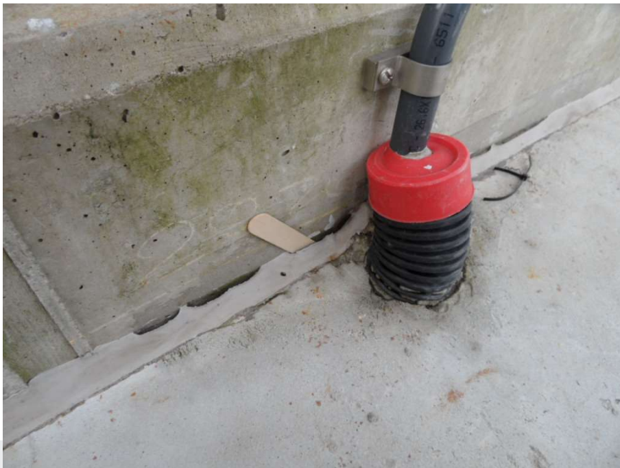
Foto: Gebrek in een afdichting.
