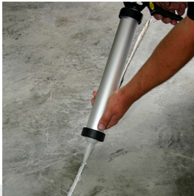
Foto: Aanbrengen voegvulmassa.
